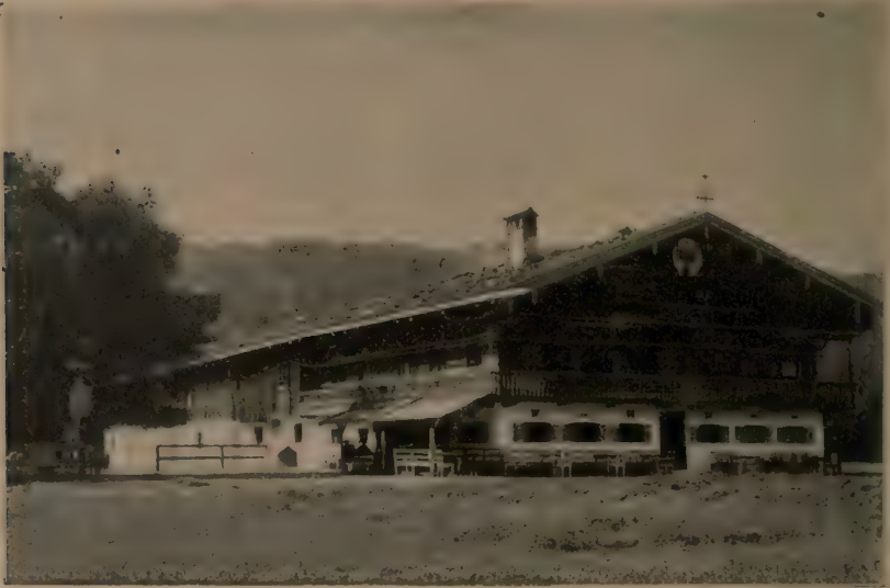
Abb. 82. Typus des oberbayerischen Bauernhauses als Beispiel des „alpinen Baustiles“ im 17. Jahrh. [Der „Bauer in der Au“ bei Tegernsee.] Original. (Vgl. hierzu Abb 81.)
